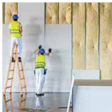
Lana de Vidrio en muro drywall
